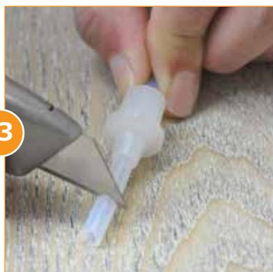
Antes de instalar la manguera de succión, inserte la boquilla ajustadora por la manguera. Córtele media pulgada más o menos de la punta de la manguera.
