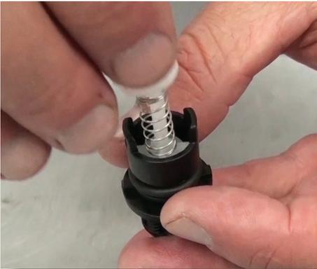
**Paso 10:** Deslice el nuevo resorte sobre el astil y coloque la nueva guía superior.
