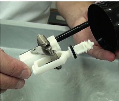
**Paso 12:** Deslice el ensamble del accionador hacia afuera.
